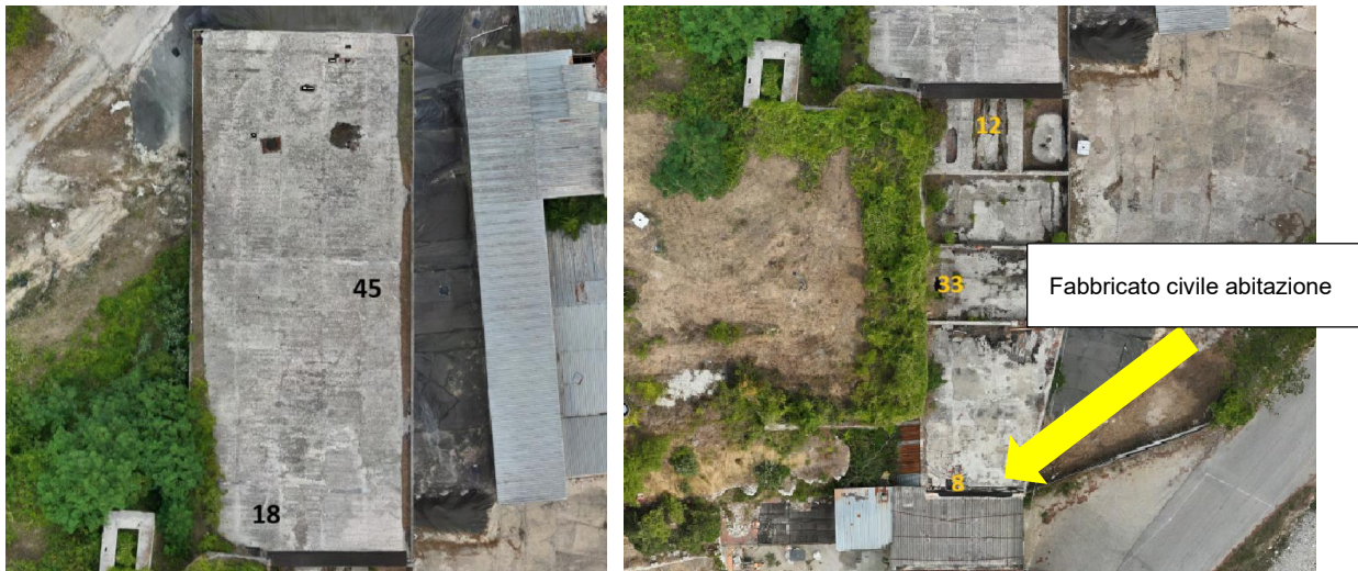
FIGURA 5-1: VISTA CAPANNONE RILIEVO DRONE
