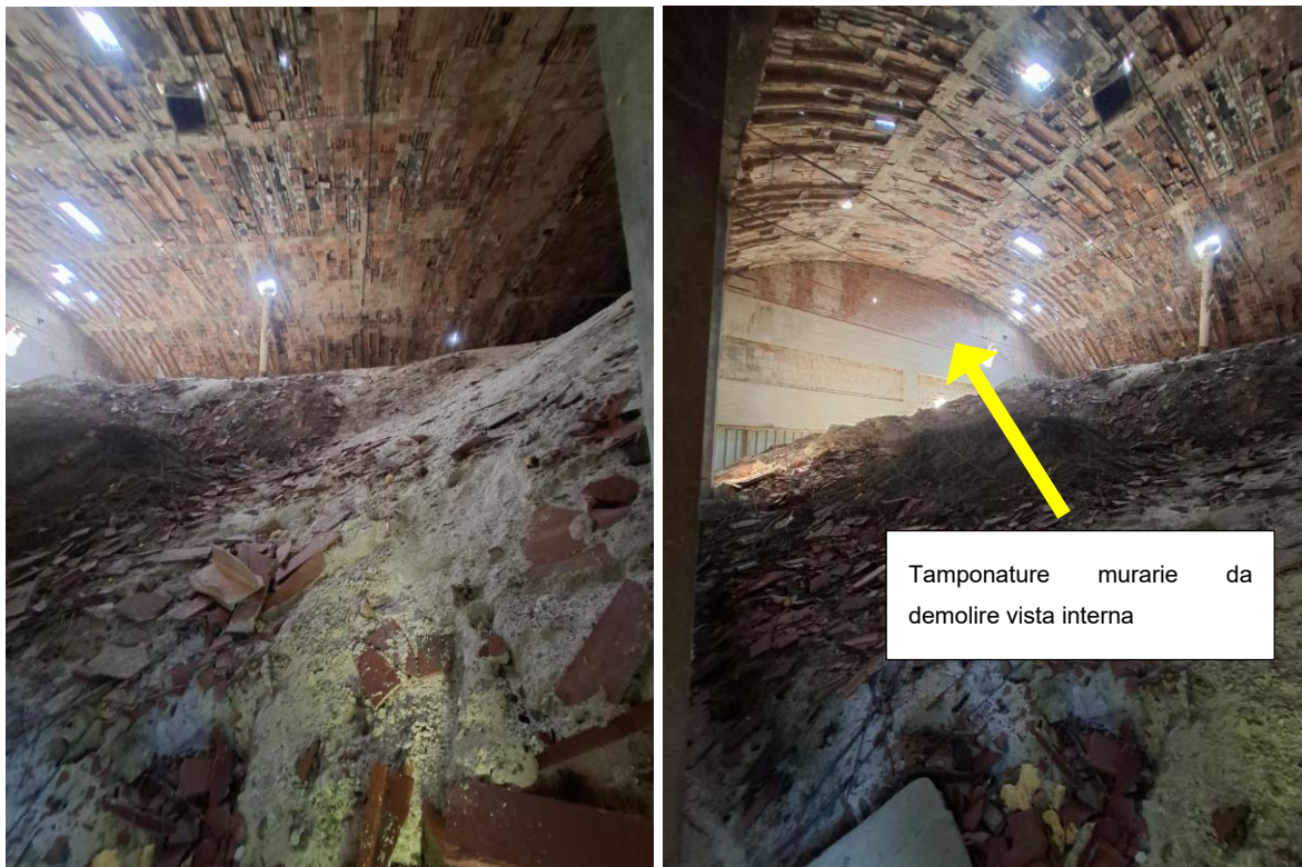
FIGURA 5-4: VISTA INTERNA DEL CAPANNONE CON INDICAZIONE DELLE TAMPONATURE MURARIE
