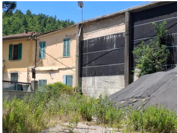
FIGURA 5-7: CAPANNONE IN ADIACENZA A CIVILE ABITAZIONE
